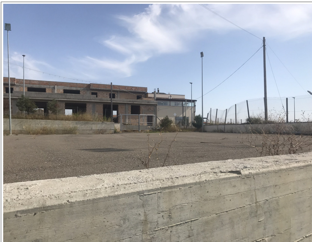
Foto 3: Piazzale di Manovra
