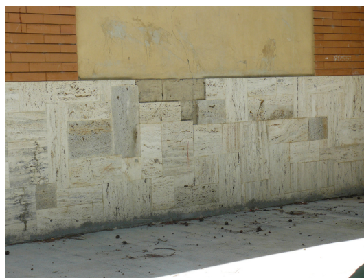
FOTO N.9 Controllo rivestimenti esterni
