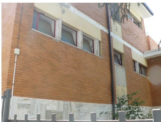
FOTO N.8 Controllo rivestimenti esterni
