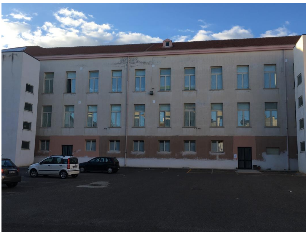
Vista facciata lato sud prospiciente il cortile interno
