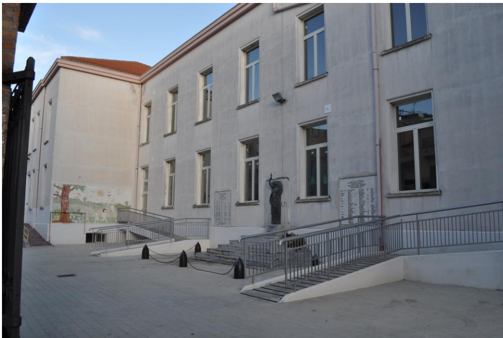
Vista facciata principale prospiciente viale Dei Caduti
