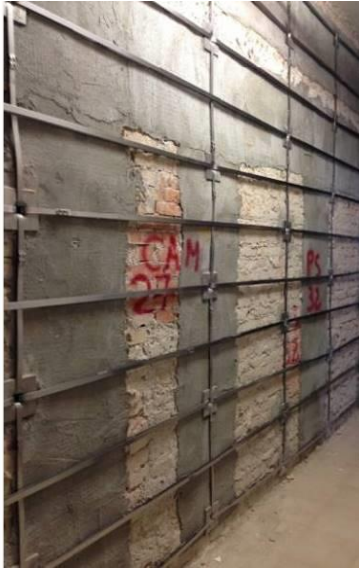
Figura 26 : Un intervento mirato a ridurre le carenze del pannello nei confronti della sollecitazione tagliante.
