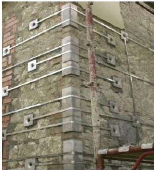
Figura 7 . La cucitura dei paramenti ortogonali realizzata IMPLICITAMENTE dalla maglia CAM
