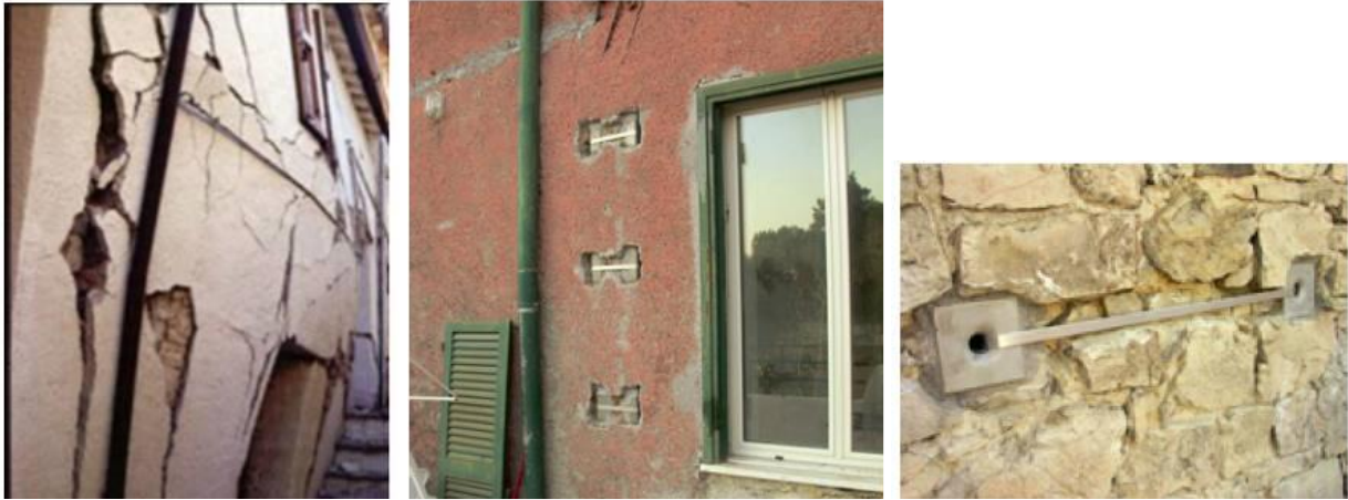
Figura 9 . Meccanismo di collasso e presidio realizzato mediante Sistema CAM
