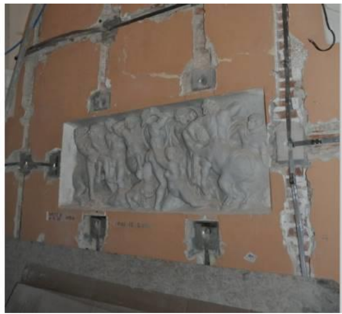
Figura 25 : Passaggio dei nastri in conservazione di un bassorilievo
