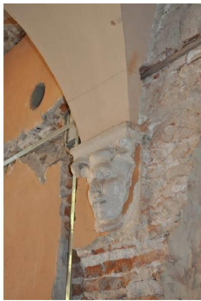
Figura 24 : Passaggio dei nastri in conservazione di un capitello .
