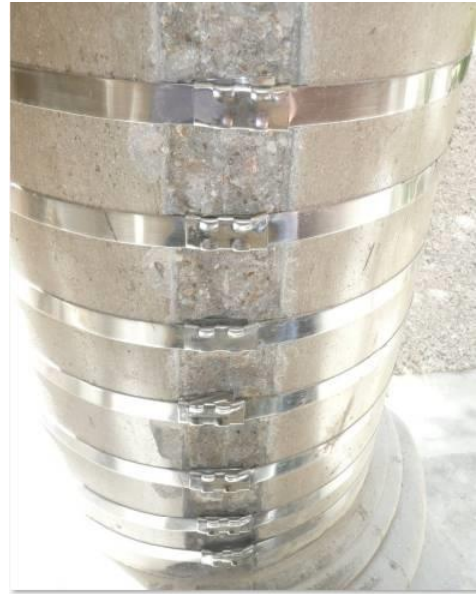
Figura 23 : vista di dettaglio.
