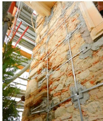
Figura 21 : La cucitura CAM in un angolo
