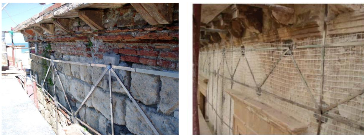
Figura 11 . Due applicazioni di CORDOLO realizzato mediante Sistema CAM
