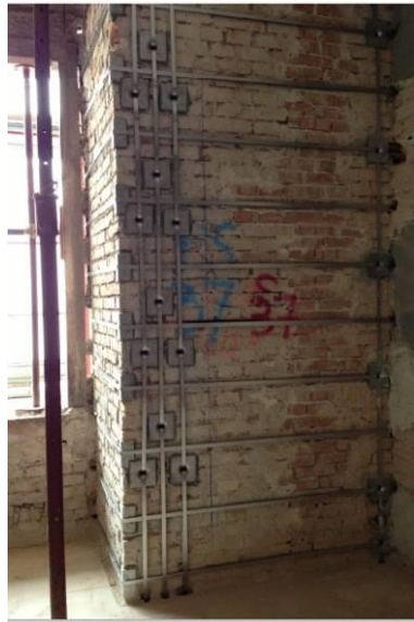
Figura 27 : Un intervento mirato a ridurre le carenze del pannello nei confronti della sollecitazione flettente.
