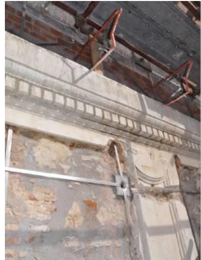
Figura 32 : il particolare del rinforzo a conservazione dei fregi.
