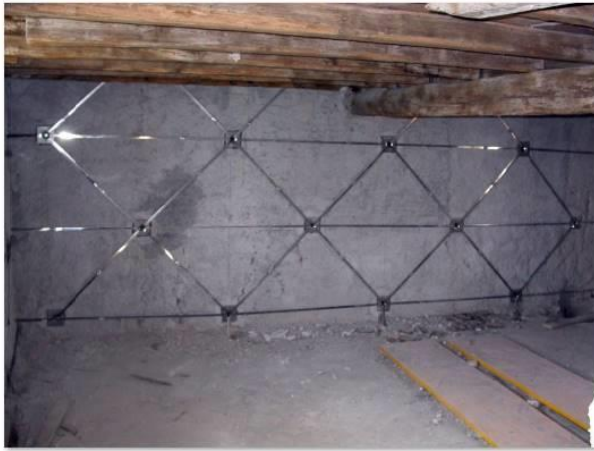
Figura 18: Una parete di sottotetto, trattata con nastri diagonali
