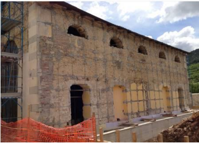
Figura 29 : La realizzazione della cucitura CAM diffusa sull'edificio
