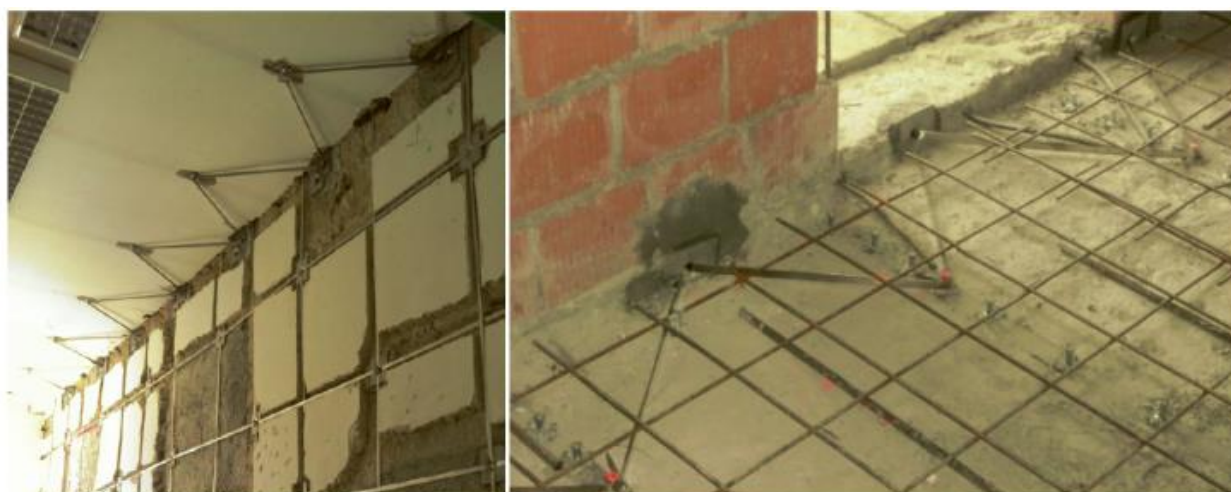
Figura 12 . Intervento di ARPIONATURA all'intradosso e all'estradosso
