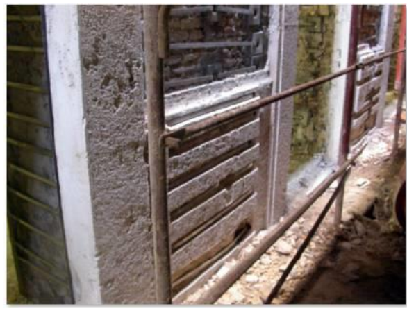
Figura 19: Dettaglio dell'intervento in facciata e conservazione delle cornici in marmo
