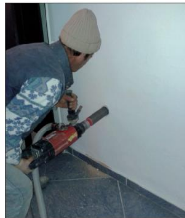
Carotatura su muratura – esecuzione
