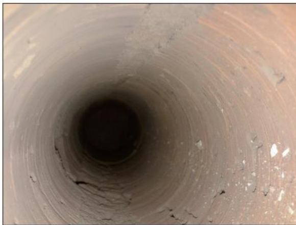
Carotatura su muratura – vista interna
