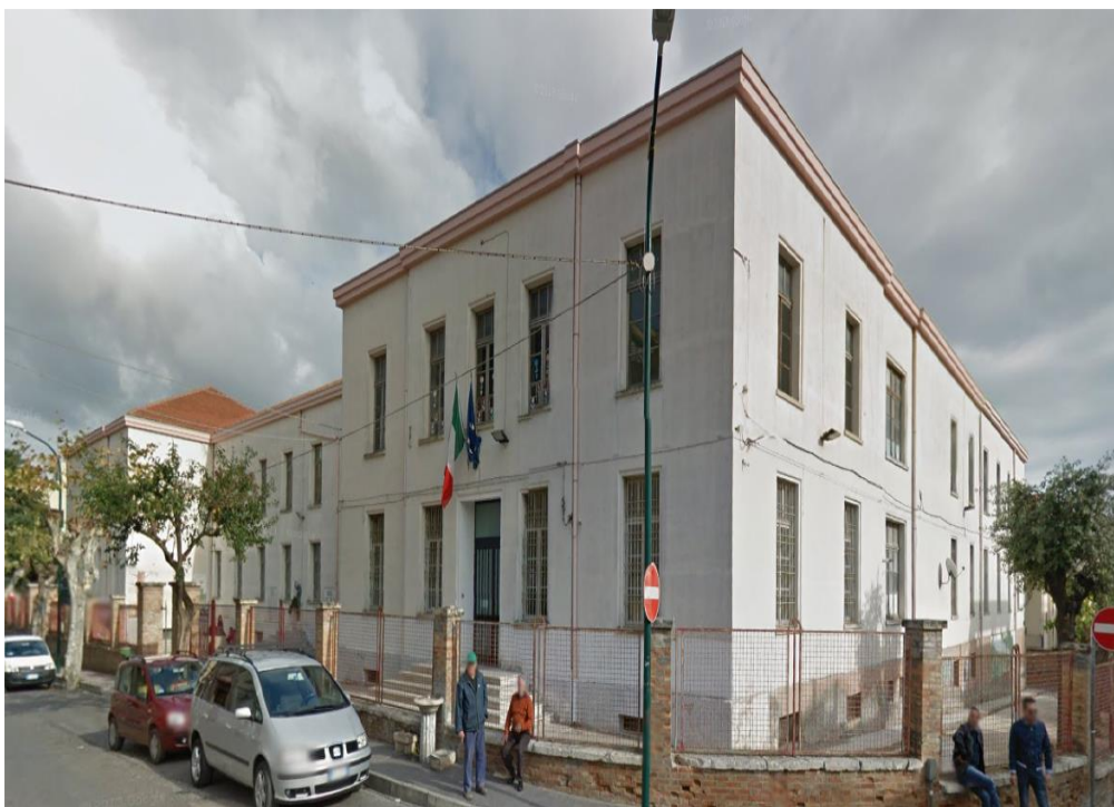
Vista dell'edificio scolastico
