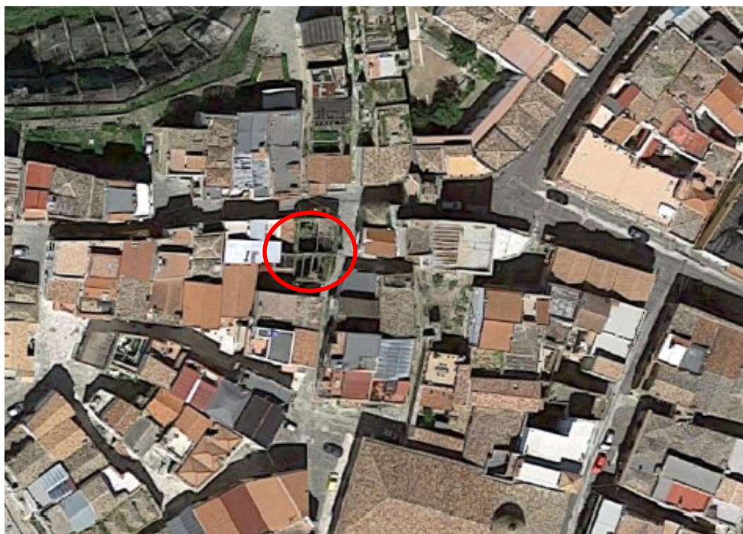
Foto 2. Vista aerea con il fabbricato oggetto di intervento
